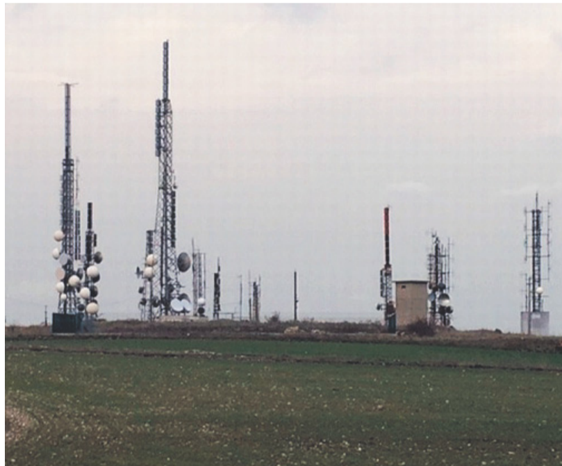
VOLTURINO Alcune delle antenne che dominano da anni l'abitato
